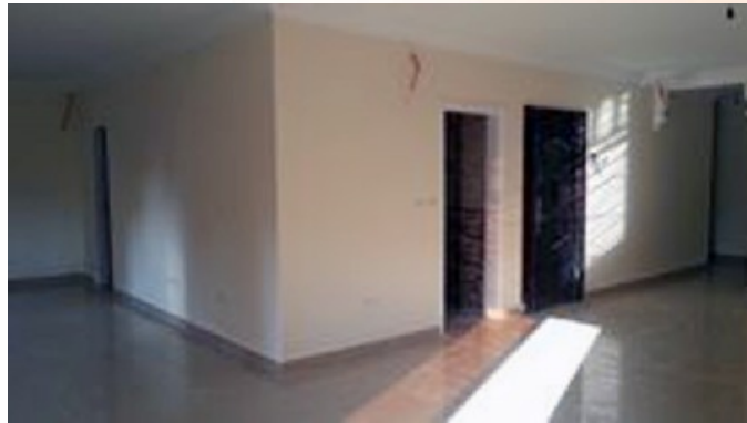
أعمال تشطيبات داخلية بكمبوند الحاسيا - الرخابج
